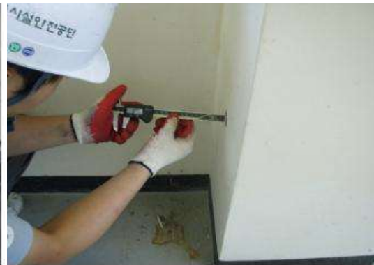
탄산화 깊이 측정
