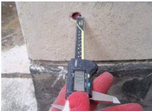
탄산화 깊이 측정
